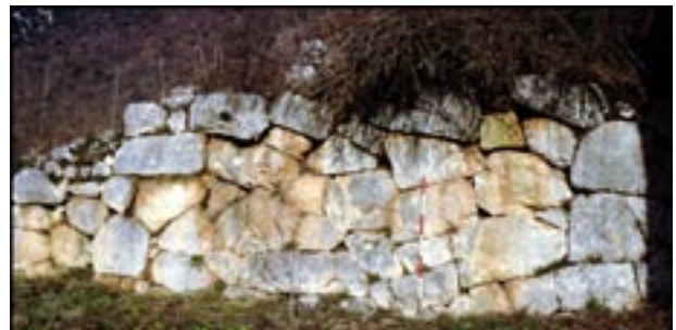
Fig. 13. Cerreto Laziale (Roma): villa in loc. Arnalicchio, particolare dell'opera poligonale.
