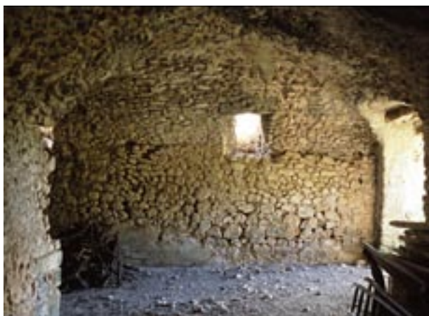
Fig. 14. Montorio Romano (Roma): villa in loc. S. Lorenzo, particolare della muratura del criptoportico.
