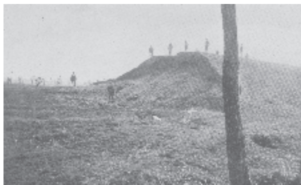
Fig. 8. Veduta dell'argine del Lagozzo alla periferia nord di Altino (Ve). Il poderoso manufatto, demolito nel secolo scorso, era la parte iniziale di una strada utilizzata probabilmente per il trasferimento stagionale delle greggi dalla città lagunare, nota per le lane, all'area prealpina e alpina.
